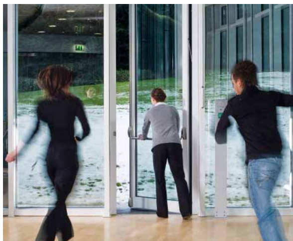
PHA 2000 mit Auslösung per Griffstange.
